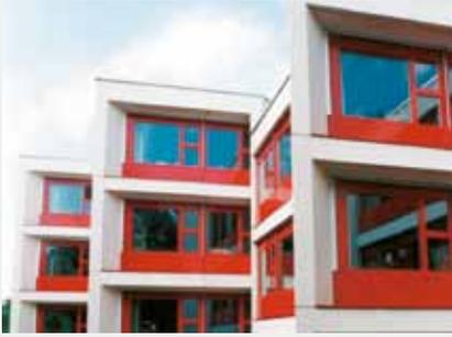
Der Schulkomplex Lättenwiese liegt in der Abflugschneise des Flughafens Zürich-Kloten. Im Rahmen der Fensterfronten-Sanierung wurden Schalldämmlüfter eingebaut. Die insgesamt 468 Fensterlüfter AEROMAT VT-WRG
